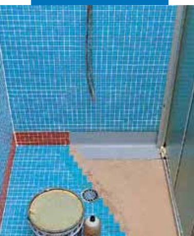
Хидроизолиране и полагане на плочки в предварително подготвена душ-кабина
